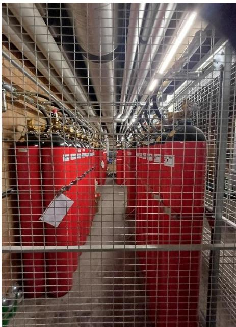
Zusätzlich zu den Brandmeldeanlagen sind 7 Sinorix N2 Trockenlöschanlagen verbaut. Diesen dienen der Löschung bei Bränden in den Trafostationen im Gebäude und der Informatik Infrastruktur. Angesteuert werden die Löschanlagen jeweils durch eine Siemens XC10 Löschezentrale welche mit der BMA verbunden sind.
