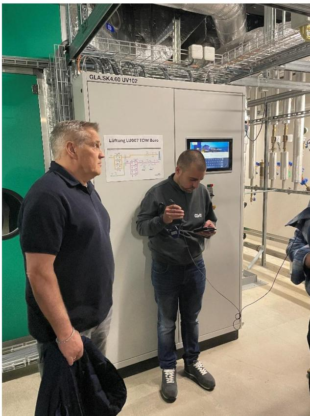
Die technischen Anlagen sind mit einem Siemens Desigo Gebäudem Managementsystem von Siemens zusammengefasst welches mehr als 11000 Datenpunkte von Gebäudeautomation und der Sicherheitstechnik zuverlässig zusammenfasst und dem Benutzer eine einfach zu bedienende Benutzeroberfläche bietet, wie Peter Jauch (hier links im Bild) erläutert.
